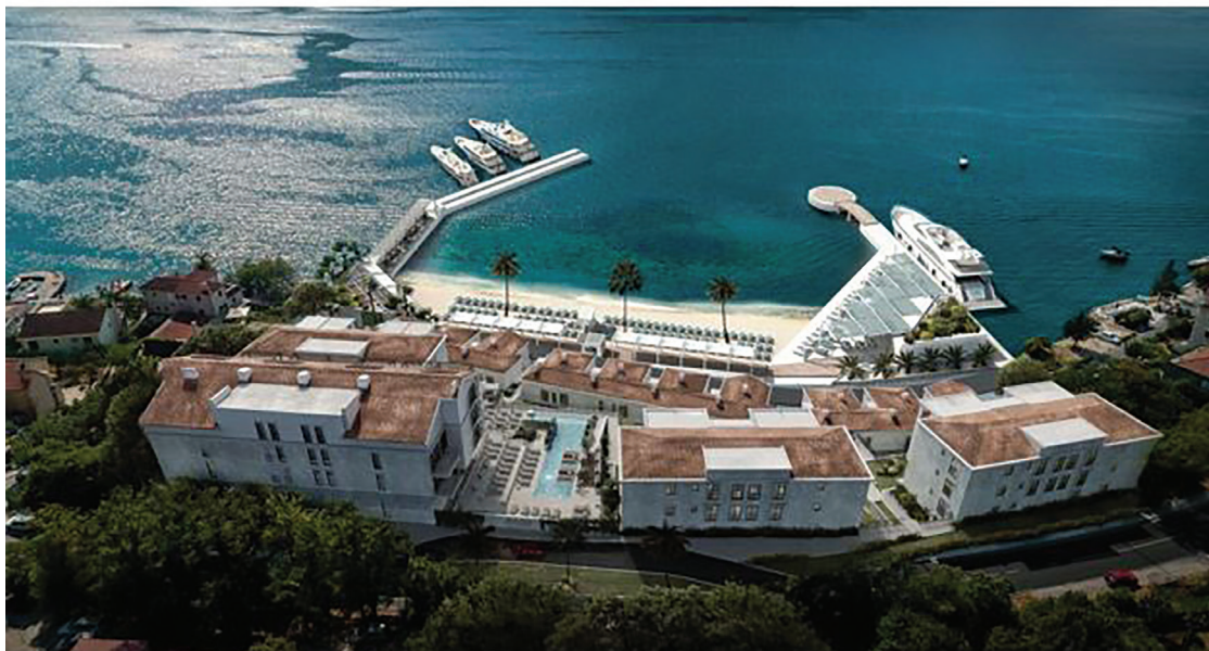
Fotografija 6: Lokalitet "Kamp" nakon izgradnje kompleksa i nasipanja plaže (preuzeto sa sajta Allure Palazzi Kotor Bay)
