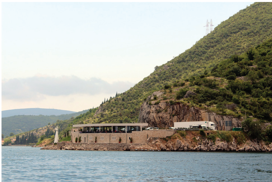
Fotografija 8: Privremeni objekat na Turskom rtu
